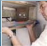
5: Motor in die Achtkantwelle schieben.
